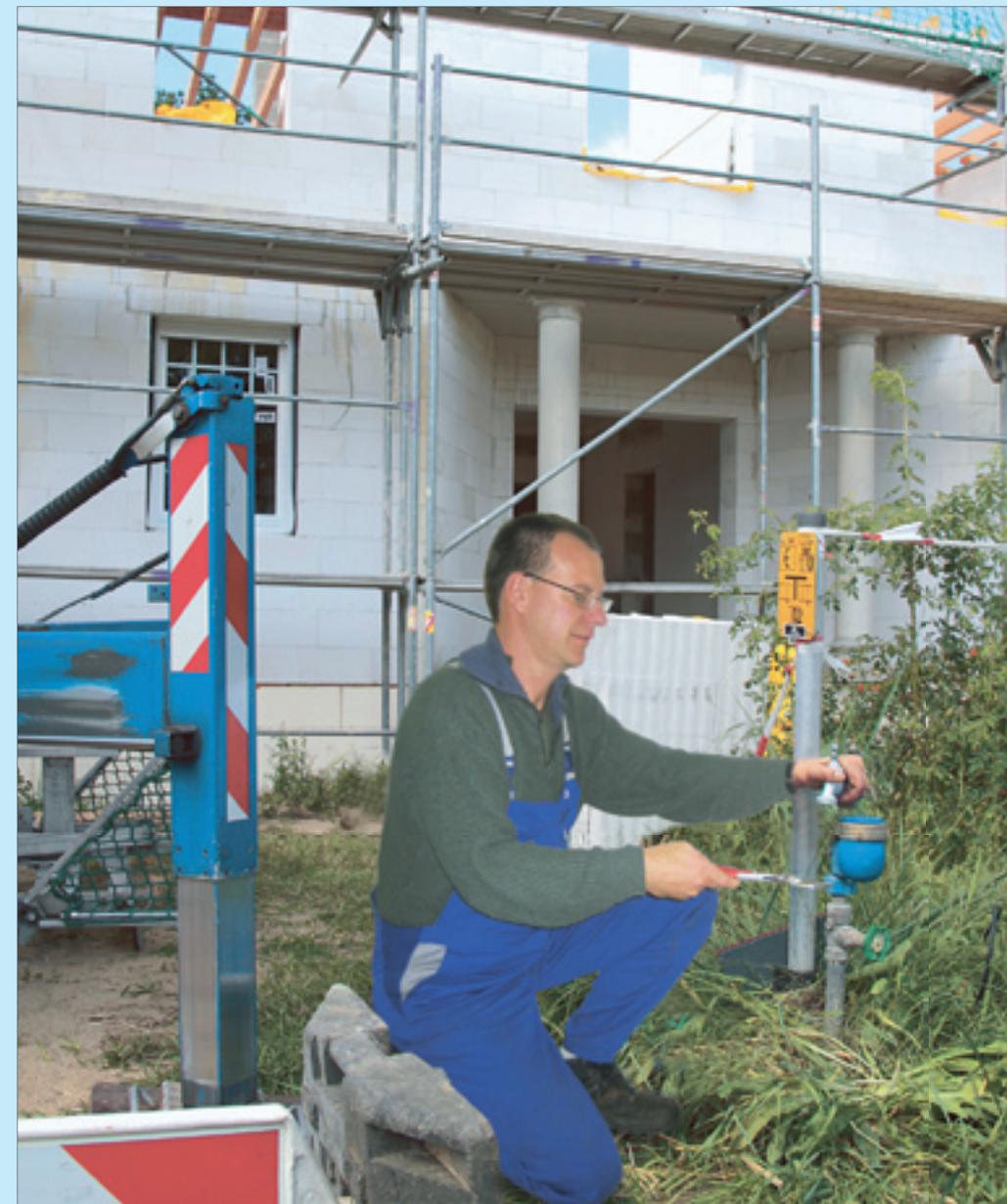
Das Setzen eines Bauwasserzählers ermöglicht die Wasserversorgung auf der Baustelle.
