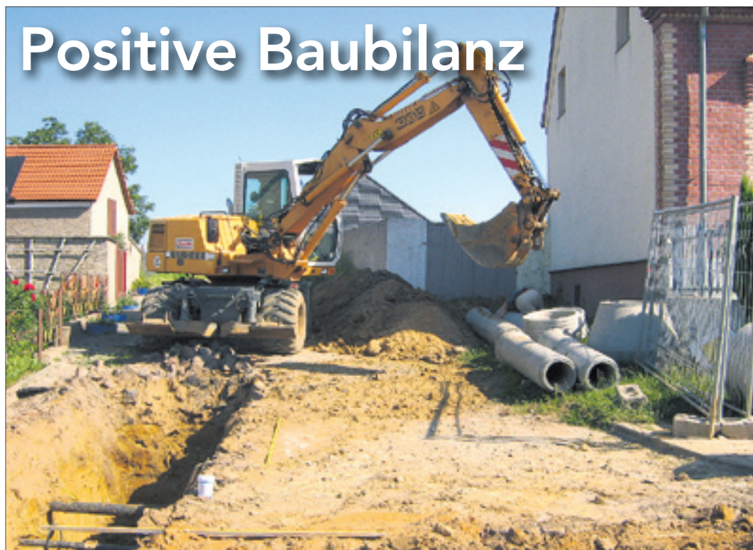
Die größte Baustelle 2007: In Groß-Santerleben wurden 800 m Trinkwasserleitung verlegt.
