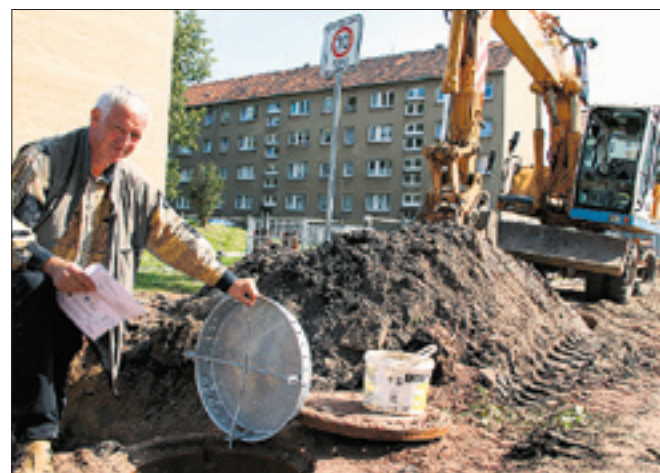
Manfred Hötling prüft eine Baustelle in der Rottmeisterstraße. Hier wurden vor kurzem der Mischwasserkanal und die Hausanschlüsse erneuert.
