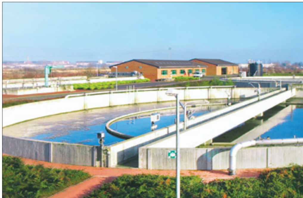
Endstation des Gommeraner Abwassers ist die moderne Kläranlage Schönebeck.
