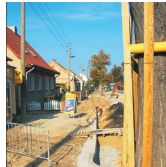
Eine Trinkwasserleitung wurde in Mückern von Privatgrundstücken der Burger Straße in den Gehwegbereich umverlegt.
