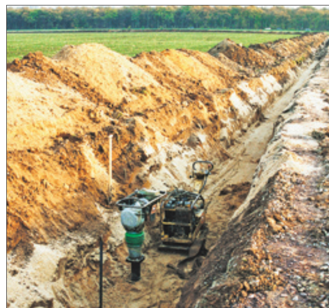
Bau der Druckleitung von Gommern nach Schönebeck.
