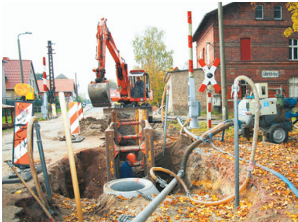
An der „Alten Schäferei“ in Lübars mussten unerwartet Schienen zurückgebaut werden.
