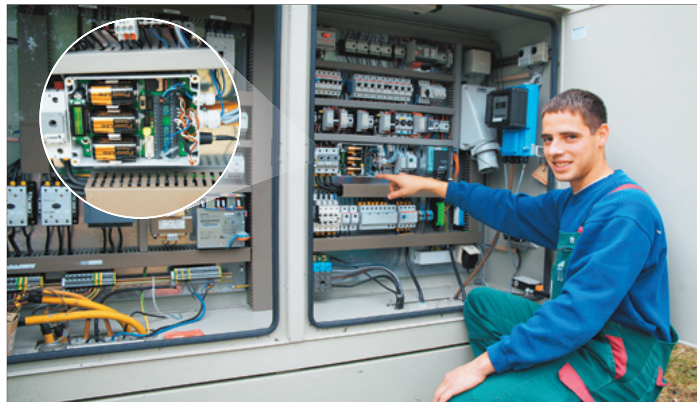
Heidewasser-Fachkraft Michael Specht demonstriert die Funktechnik (siehe Ausschnitt) im Pumpwerk Plötzky.
