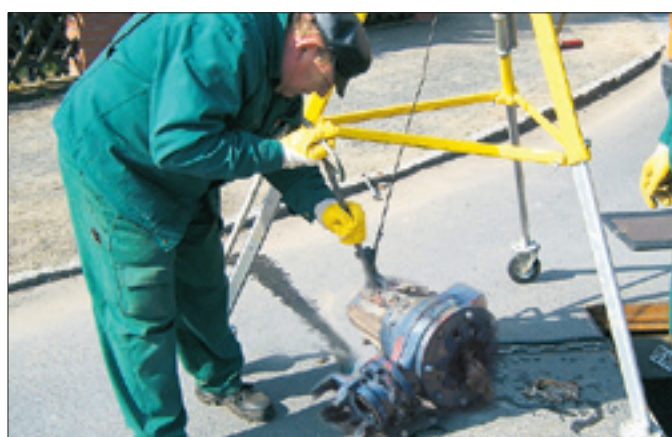
Die Reparatur verstopfter Pumpen ist sehr aufwändig.
