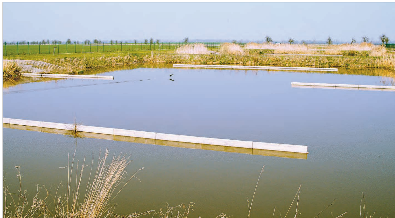
Die Teichkläranlage (Fachbegriff: unbelüftete Oxydationsteichanlage) funktioniert in Ladeburg ausschließlich mithilfe natürlicher Prozesse ganz ohne zusätzlichen Strom.
