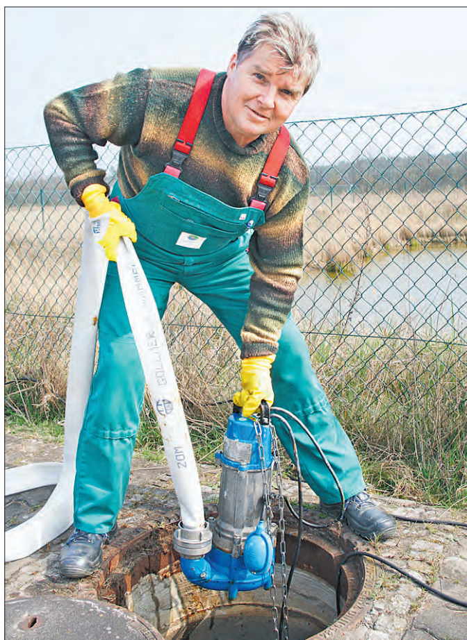
Heidewasser-Mitarbeiter Frank Schönrock prüft, ob die Pumpe vorschriftsmäßig arbeitet, die Wasser aus dem Brunnen eines Feuerlöschteichs (hinten) ins Pumpwerk Stegelitz leitet.
