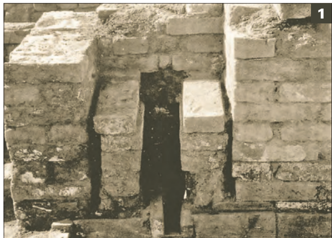
Wasseranlagen im Indus bei Mohenjo-Daro (heute Pakistan): Wassertoilette (1), Wasserleitungen (2) und Brunnen (3).
