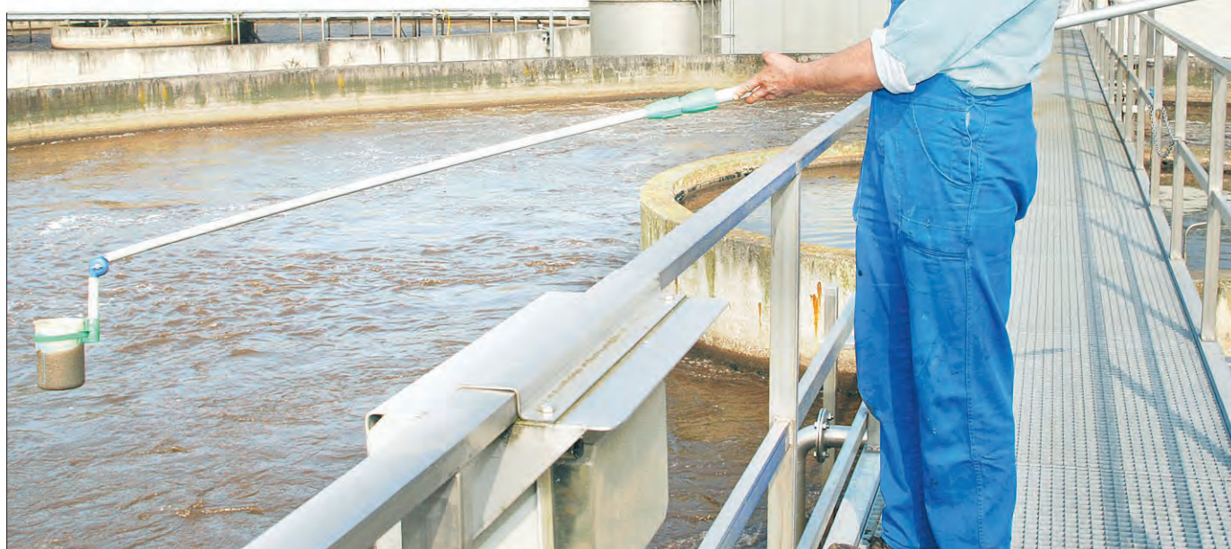
Klärwart Klaus Tierling nimmt in der Kläranlage Möckern täglich Abwasserproben. Er sorgt dafür, dass das gereinigte Schmutzwasser schlussendlich mit Bestwerten in die Ehle abfließen kann.
