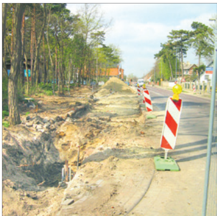
Eines von vielen erfolgreich abgeschlossenen Bauprojekten 2009: Im Bereich der Königsborner Straße in Heyrothsberge wurde im Zuge des Bundesstraßen-Ausbaus die Trinkwasserleitung erneuert.
