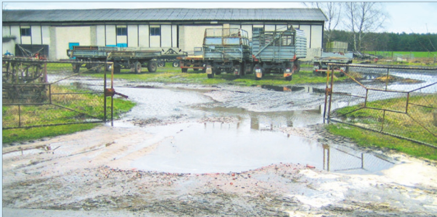
Auch unverschuldet kann einen ein Wasserrohrbruch treffen – wie im Falle dieses landwirtschaftlichen Betriebs in Krüssau im Jerichower Land. Um eine solche Sintflut nicht selbst auszulösen, sollte man marode Hausinstallationen schleunigst erneuern lassen.
