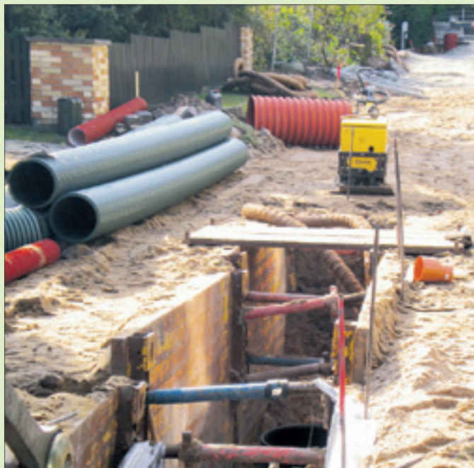
In der Kleinen Wiesenstraße in Gommern wurde in diesem Jahr ein Schmutzwasserkanal für den zentralen Anschluss ans Abwassernetz gelegt.
