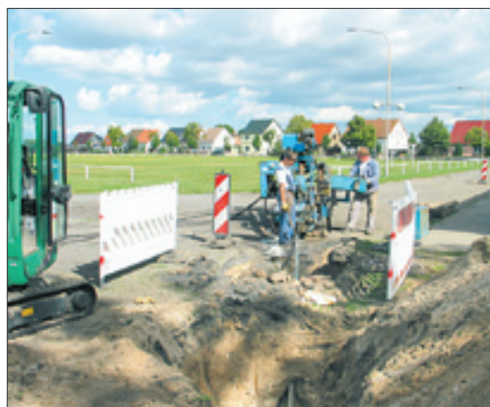
Bei dem horizontalen Spülbohrverfahren wird der Bohrkopf in das Erdreich gedreht.
