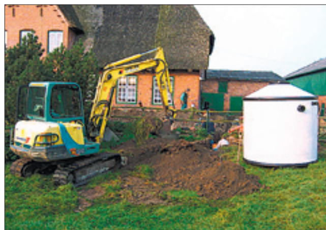
Installation einer biologischen Kleinkläranlage.
