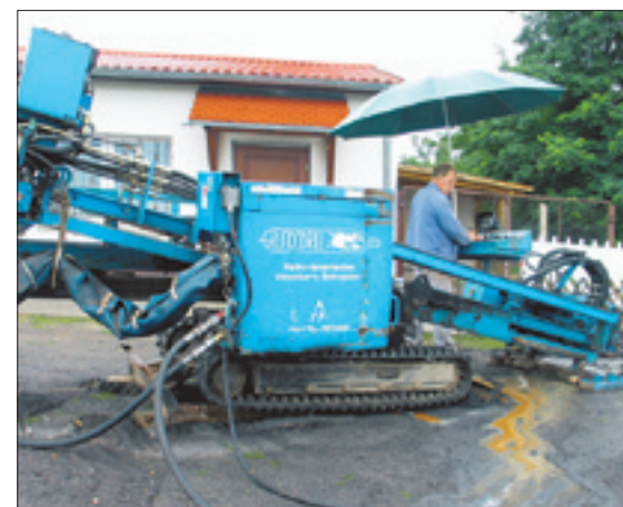
Die Bohrungen müssen permanent überwacht, präzise gesteuert und geortet werden.
