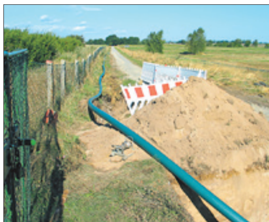
Bevor die Leitungen eingezogen werden, streckt man sie an der Straße entlang vor.
