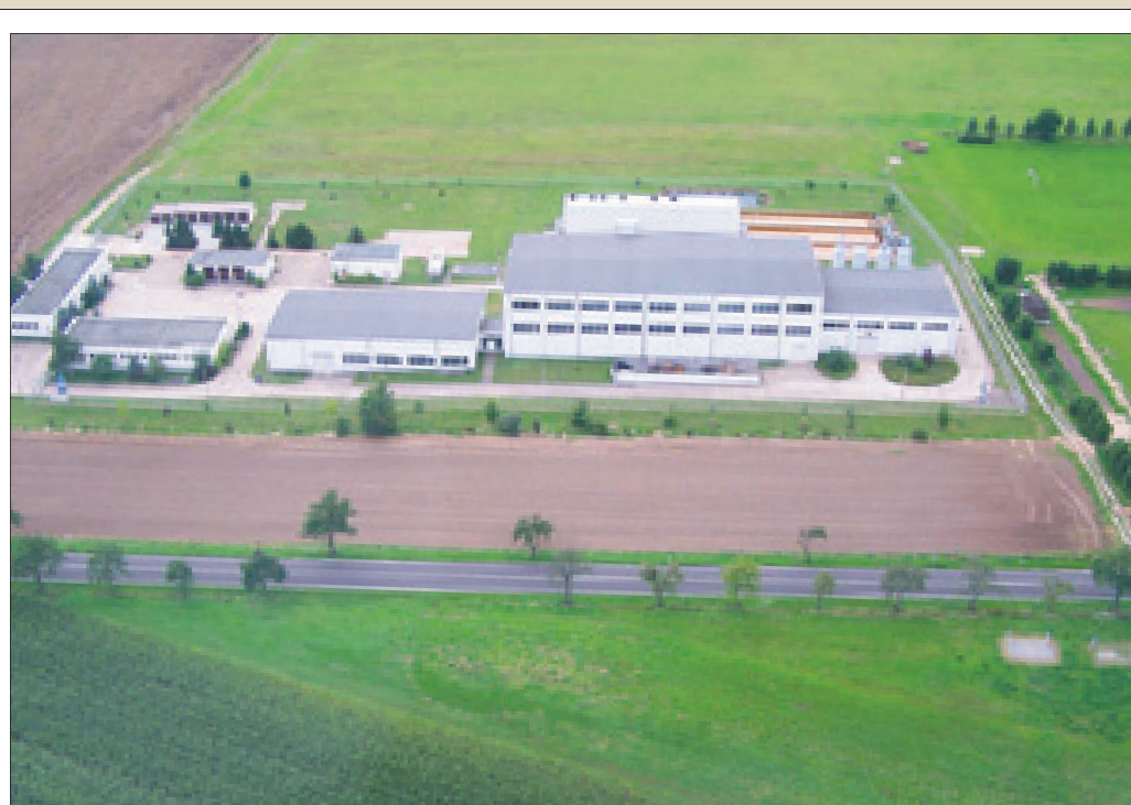
Das Wasserwerk Lindau aus der Vogelperspektive.
