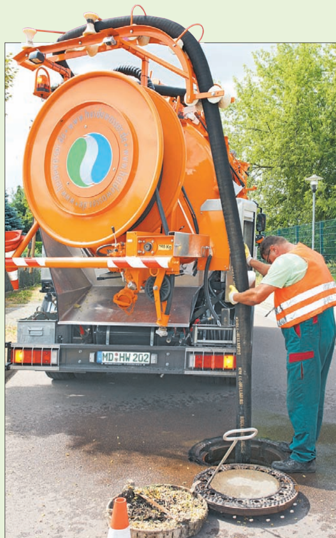
Kanalnetzarbeiter des Heidewasser-Meisterbereiches Möckern reinigen die Kanäle mit modernen Hochdruckspülwagen.
