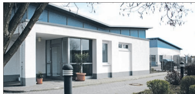
Die Anlage im Upstallweg in Möckern gehört seit dem Jahr 1999 der Heidewasser GmbH.
