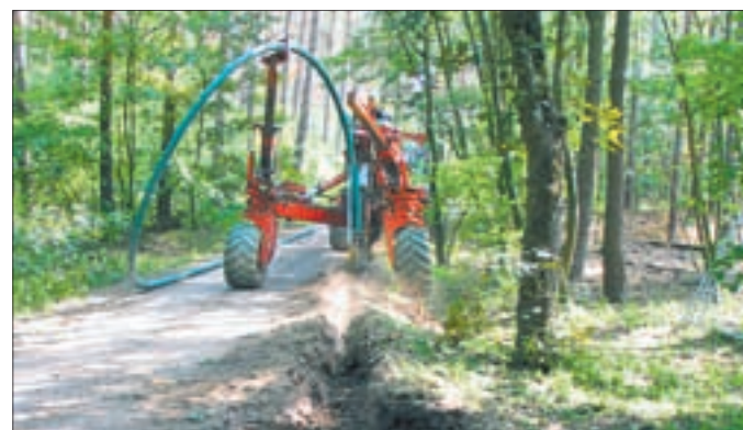
Die Abwasserdruckleitung von Grochewitz nach Hundeluft ist über einen großen Teil der Strecke eingepflügt worden.
