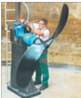
Abwasserexperte Frank Wienig sichert das Kabel des Rührwerkes im Nachklärbecken.
