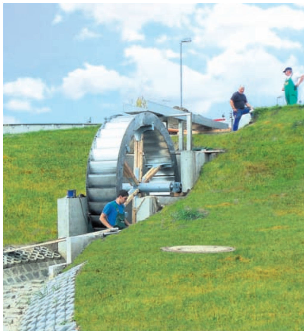
Umweltfreundlich: Der Abwasserverband Haldensleben leistet mit dem Wasserrad einen weiteren Beitrag zur nachhaltigen Energiegewinnung.
