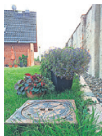
Hausanschlusschächte müssen gut sichtbar und zugänglich sein.
