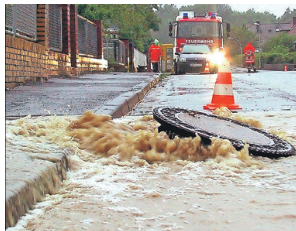
Wenn die Kanalrohre volllaufen, droht ein Rückstau in die Keller.
