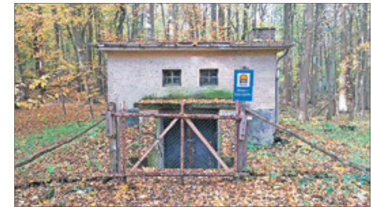
Dieses Wasserwerk soll stillgelegt werden. Foto: Heidewasser
