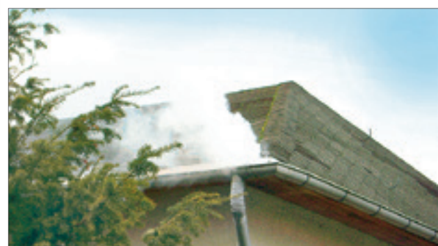
Diese Dachentwässerung ist an das öffentliche Kanalnetz angeschlossen.
