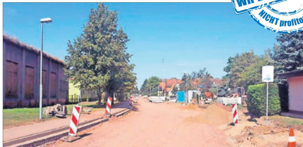
In Ziepel sollen neue Druckrohre die Geruchsproblematik durch stehendes Abwasser lösen. Foto: Heidewasser
