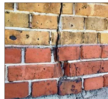
Die Risse in den Mauern wurden ausgebessert, alle Fugen ausgefräst und durch roten Mörtel ersetzt.
