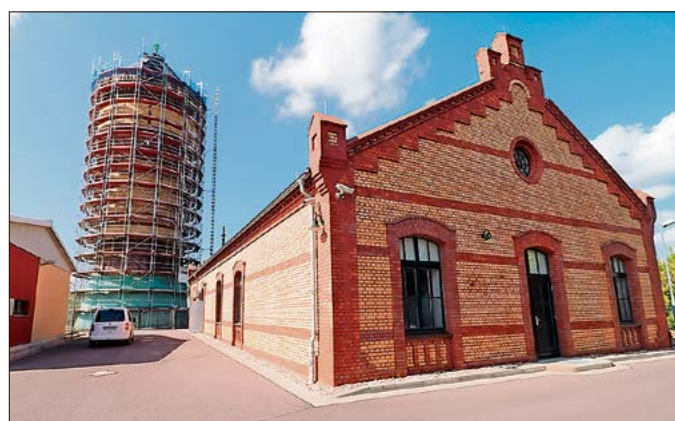
2018 zeigte sich der Turm noch komplett eingerüstet. Im Vordergrund ist der Meisterbereich Zerbst zu sehen, der einst wie der Turm zum Wasserwerk gehörte. Foto: SPREE-PR/ Petsch
