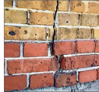
Die Risse in den Mauern wurden ausgebessert, alle Fugen ausgefräst und durch roten Mörtel ersetzt.
