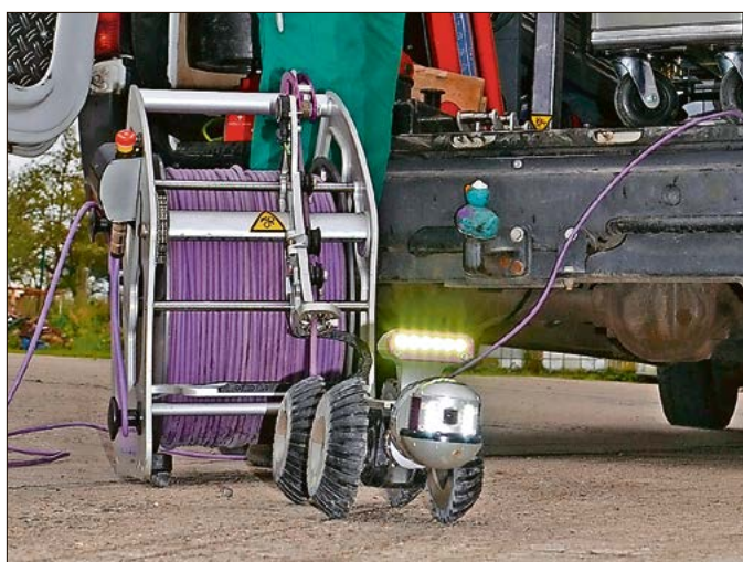
20 Kilometer Kanal wurden bei der letzten Inspektion befahren.
