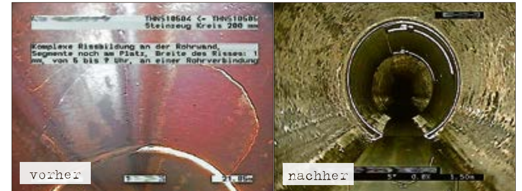
Links sind Risse im Schacht zu sehen, rechts die fest verankerte Edelstahl-Manschette. Fotos (2): Heidewasser
