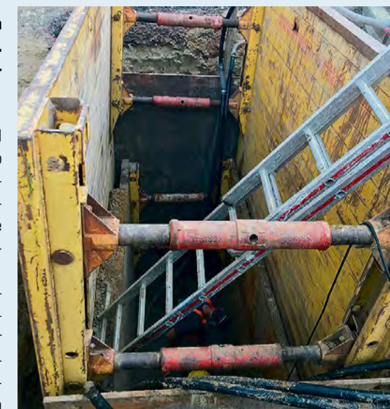
Mehr als vier Meter tief lagen die Abwasserleitungen, die ausgebessert werden mussten. Foto: Fahrenkamp/AVH
