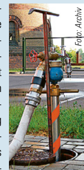
Angeschlossenes Standrohr. Foto: Archiv
