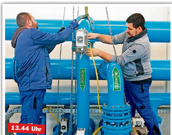
Es geht ans „Eingemachte“. Die Reinigung der Schlamm- und Rohwasserklappen ist komplexe Handarbeit und zeitaufwendig. Doch die beiden Fachmänner (li. Michael Grünwald) funktionieren perfekt im Team.
