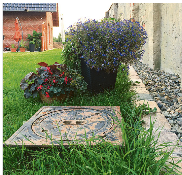
Ihr Hausanschlussschacht muss gut zugänglich sein. Foto: SPREE-PR/Wöhler
