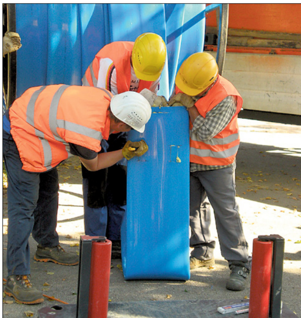
Neben Inlinern aus Glasfaserschichten werden auch Kunststoff- und Textilschläuche für das Verfahren der grabenlosen Kanalsanierung verwendet. Der Zugang zu den Hausanschlüssen wird nach dem Einziehen des Schlauches mit ferngesteuerten Fräsröbtern geöffnet.
