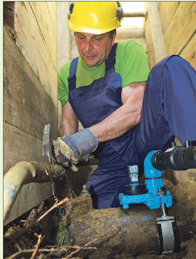
Im Zuge des Ausbaus der Kreisstraße 1245 in Zerbst hat die Heidewasser GmbH die Trinkwasserleitungen komplett ausgewechselt. Dabei wurden vorhandene Bleianschlüsse ersetzt.
