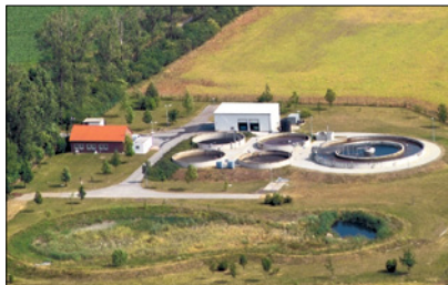
Die Kläranlage Loburg aus der Vogelperspektive.
