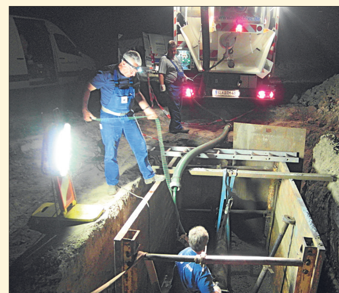
Licht an, Wasser marsch: Mit einem Hochdruckspülwagen reinigen Heidewasser-Mitarbeiter einen Rohrschnitt bei Ivenrode.
