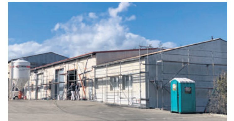
Die Hülle der Fahrzeughalle wird – wie auch der Anbau im Vordergrund – ausgebessert und verputzt.
