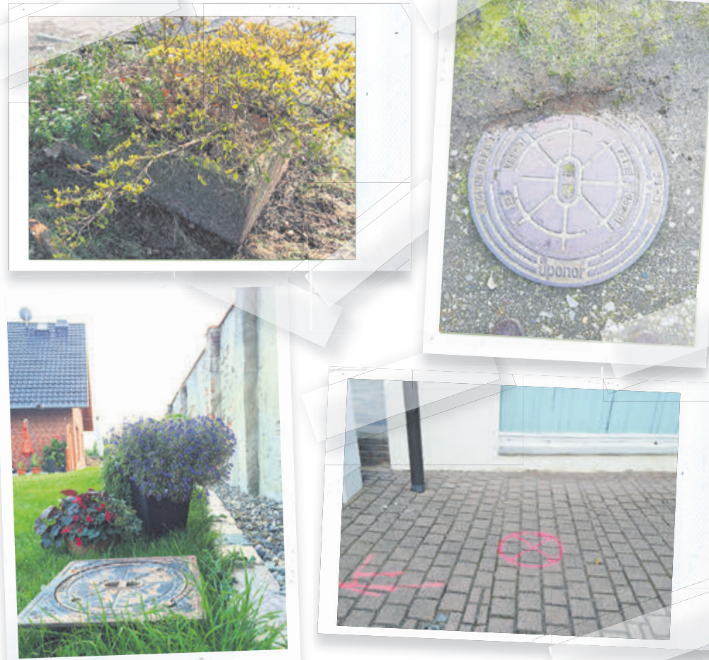
Kaum zu glauben: Auf allen Fotos sind Revisionsschächte fotografiert worden – zum Teil komplett überbaut.
