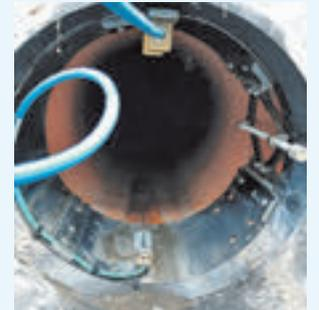
Die Sensoren messen Füllstand und Fließgeschwindigkeit im Kanal, woraus sich die Durchflussmenge ergibt. Eingebaut wurde die Vorrichtung vom Meisterbereich Zerbst.
