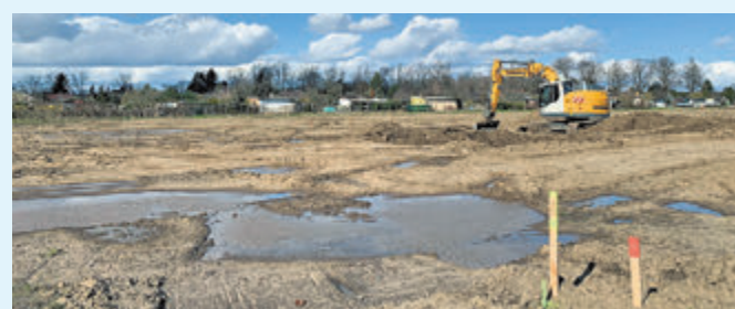
Wasserlachen auf dem Baugrund zeigen undurchlässige Schichten an.
