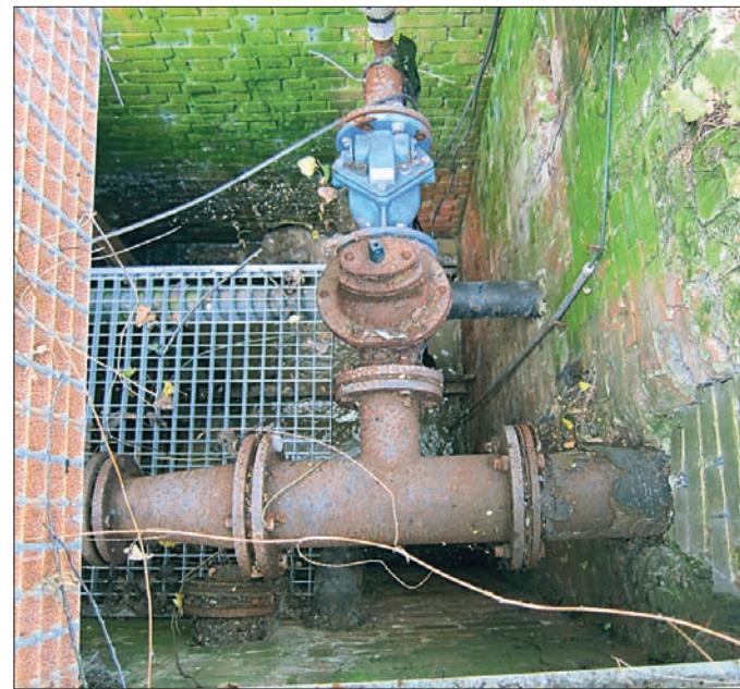
Braucht dringend eine Rundumerneuerung: Als nächstes lässt der Eigenbetrieb das alte Pumpwerk „Albert-Schweitzer-Straße“ sanieren.
