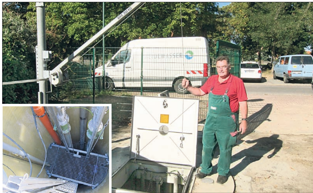
Das macht Freude: Ein Blick in den Pumpwerksschacht am Kellerberg offenbart den Abwassertechnikern der Heidewasser GmbH nun moderne Technik.
