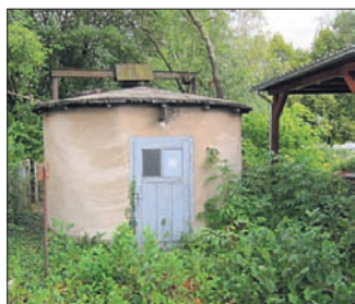
Das alte Pumpwerksgebäude an der Albert-Schweitzer-Straße.
