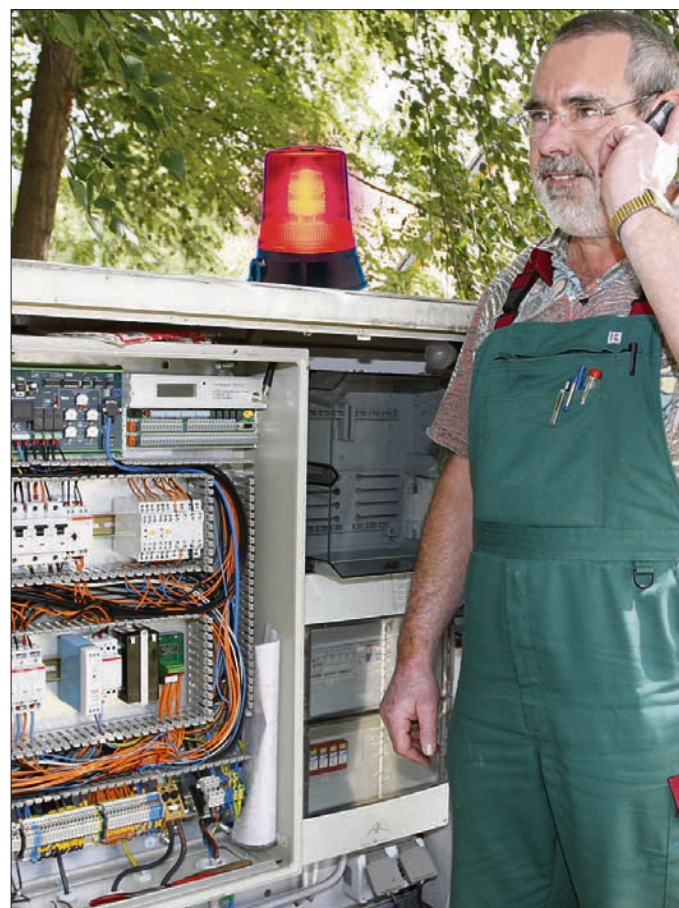
Gibt ein Pumpwerk Warnsignale ab, ist es wichtig, sofort die Heidewasser GmbH zu informieren.
