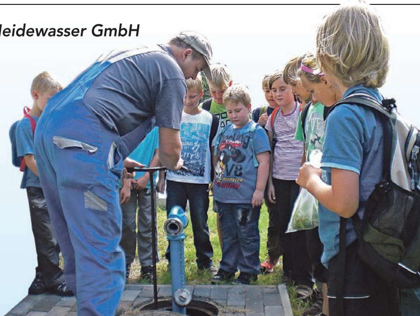
Steffen Lönning von der Heidewasser GmbH zeigte den Hortkindern der Kita „Kinderland“, wie ein Standrohr geöffnet wird, um Wasser zu entnehmen.
