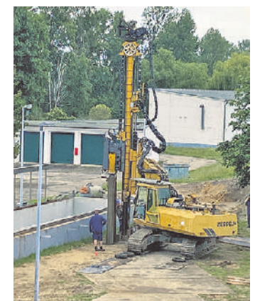
Eigens gesetzte Spundwände werden das Grundwasser in der späteren Baugrube zurückhalten.
