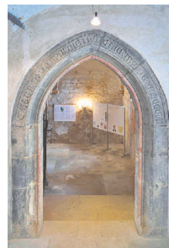
Eine Spitzbogentür führt in die historische Krypta.
