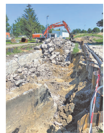
Eigens gesetzte Spundwände werden das Grundwasser in der späteren Baugrube zurückhalten.
