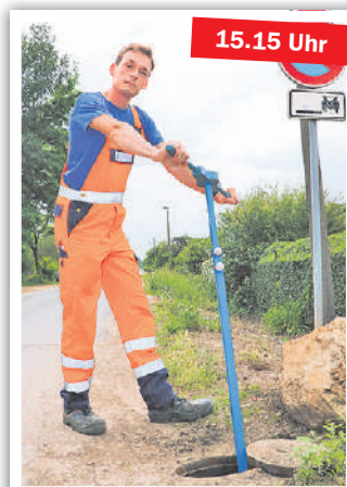
▲ Hier wird ein Wasserschieber geschlossen. Dank dieser überall im Trinkwassernetz eingesetzten Anlagenteile können einzelne Abschnitte für Arbeiten vom Netz genommen werden.
