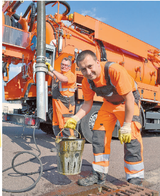
Derzeit sind die Saug-Spülwagen in den Meisterbereichen noch u. a. zur Reinigung von Sinkkästen im Einsatz. Mit dem Jahreswechsel startet die Heidewasser GmbH in die dezentrale Entsorgung.
