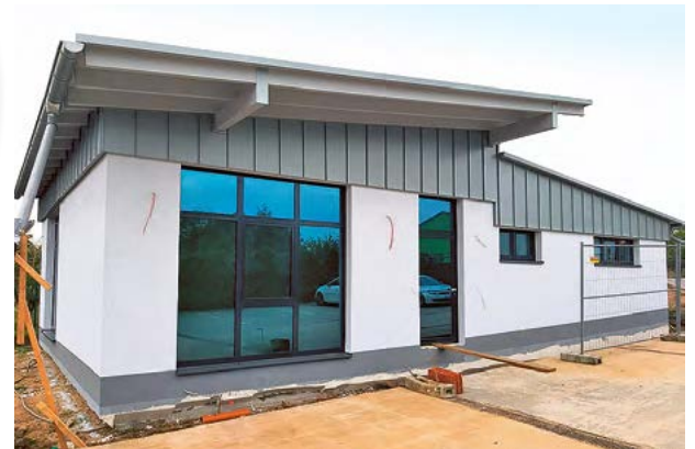
Anfang Dezember wird dieses Gebäude mit Büro und Sanitäranlagen fertig sein. Die Fahrzeughalle mit Werkstatt kann erst im Februar eröffnet werden. Dann ziehen die Mitarbeiter des Meisterbereiches Haldensleben um.
