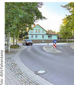
Der betroffene Kreisverkehr in Althaldensleben. Foto: AVH/Fahrenkamp
