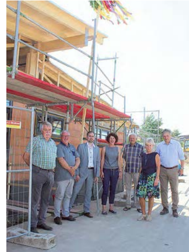
Das Richtfest im Sommer feierten die Heidewasser-Geschäftsführer (2. und 4. v.l.) mit Beteiligten und AZV-„Aller-Ohre“-Geschäftsführerin Evelin Silbermann (vorn).
