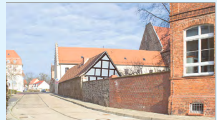
Vor dem Gymnasium Francisceum in Zerst muss die Trinkwasserleitung erneuert werden. Die Maßnahme wird von einem Zerst Ingeieurbüro betreut.
