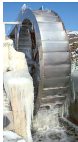
Das Wasserrad auf der Kläranlage in Hillersleben.
