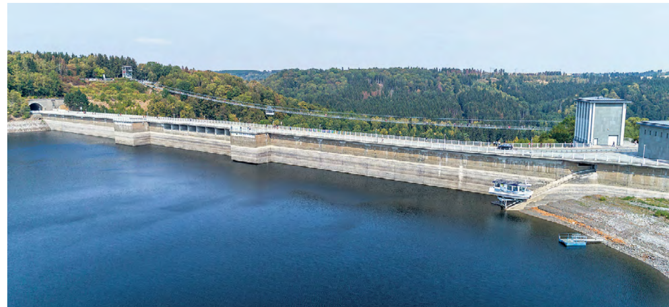
Die Rappbodetsperre (im Bild), die Zillierbachtalsperre und der Teufelsteich haben in den letzten 20 Jahren im Schnitt 45,98 Mio. m 3 Rohwasser pro Jahr bereitgestellt – 37% des Gesamtverbrauchs in unserem Bundesland.
