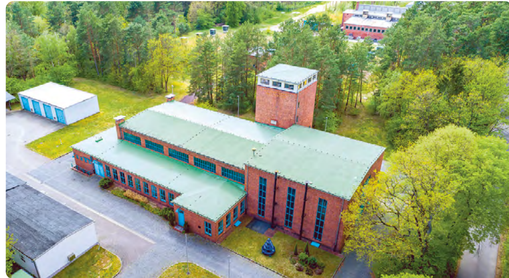
Moderne Technik sorgt im Wasserwerk Colbitz für die Trinkwasserversorgung von 500.000 Menschen.
