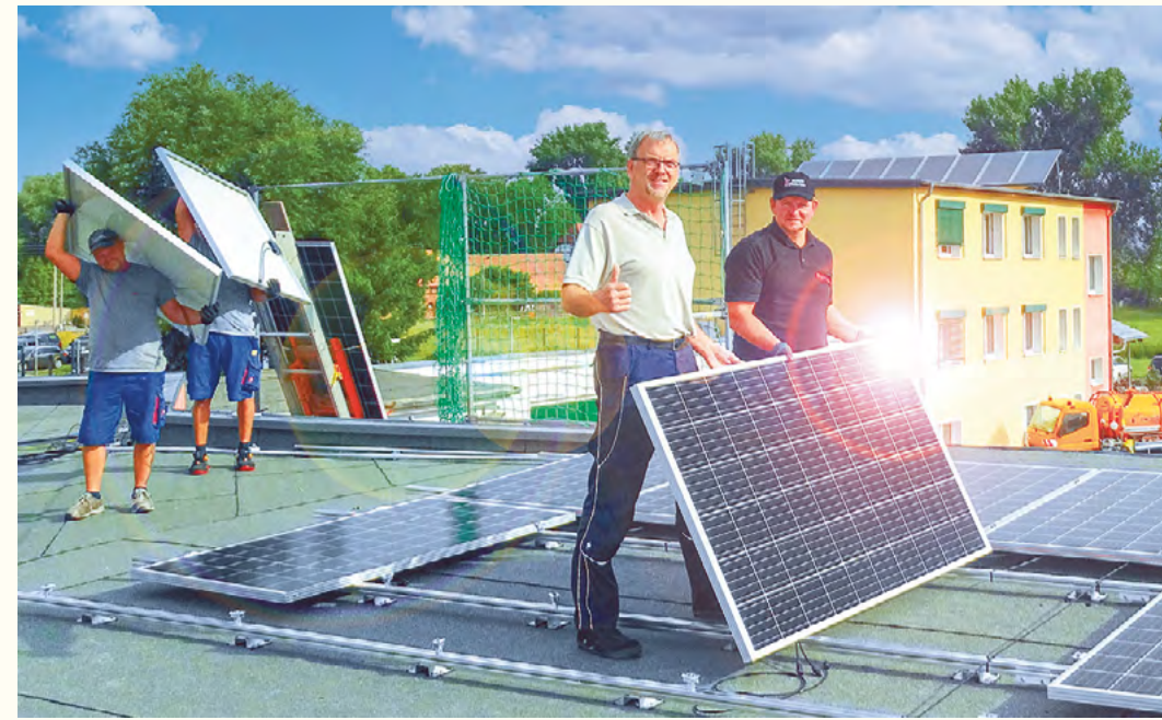
Thomas Lange vom AVH und der Elektro-Runge-Geschäftsführer Christian Runge (r.) packen mit an, damit die Solar-Module zügig eingebaut werden können. Sie wurden im Juli auf dem Garagendach des AVH-Geländes am Burgwall installiert.
