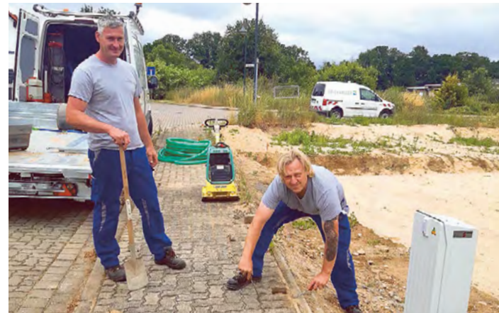
Die beiden Bauplätze-Kollegen Mathias Ulrich (l.) und Mirko Siebert. Ulrich, gelernter Gas- und Wasserinstallateur, leitet den Zerbster Trupp seit Mai als Vorarbeiter.
