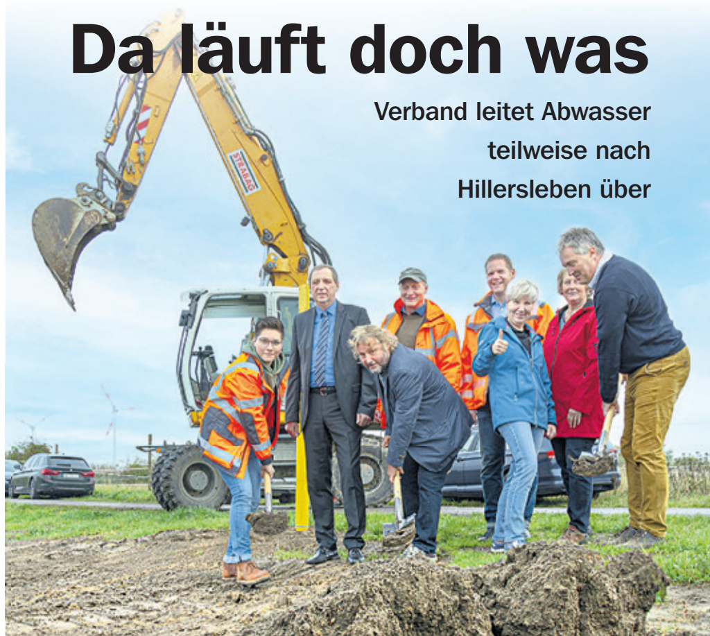
Mit dem Spatenstich startete eine dreimonatige Bauzeit für die 7,5 Kilometer lange Druckrohrleitung. Neben den Verbandsgeschäftsführern Evelin Silbermann (3. v. r.) und Achim Grossmann (2. v. l.) eröffneten Vertreter der Verbandsversammlungen, der Baufirma und der Verbände die Arbeiten. Foto: SPREE-PR/Wähler
