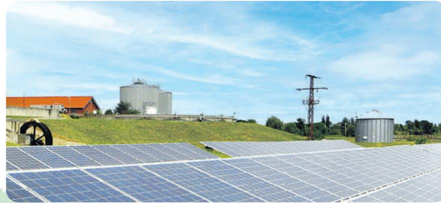
Der alte Gasspeicher (rechts) auf der Kläranlage Hillersleben wird in diesem Jahr durch einen größeren ersetzt. Er liefert zuverlässig und wetterunabhängig Brennstoff für die BHKW. Foto: AVH
