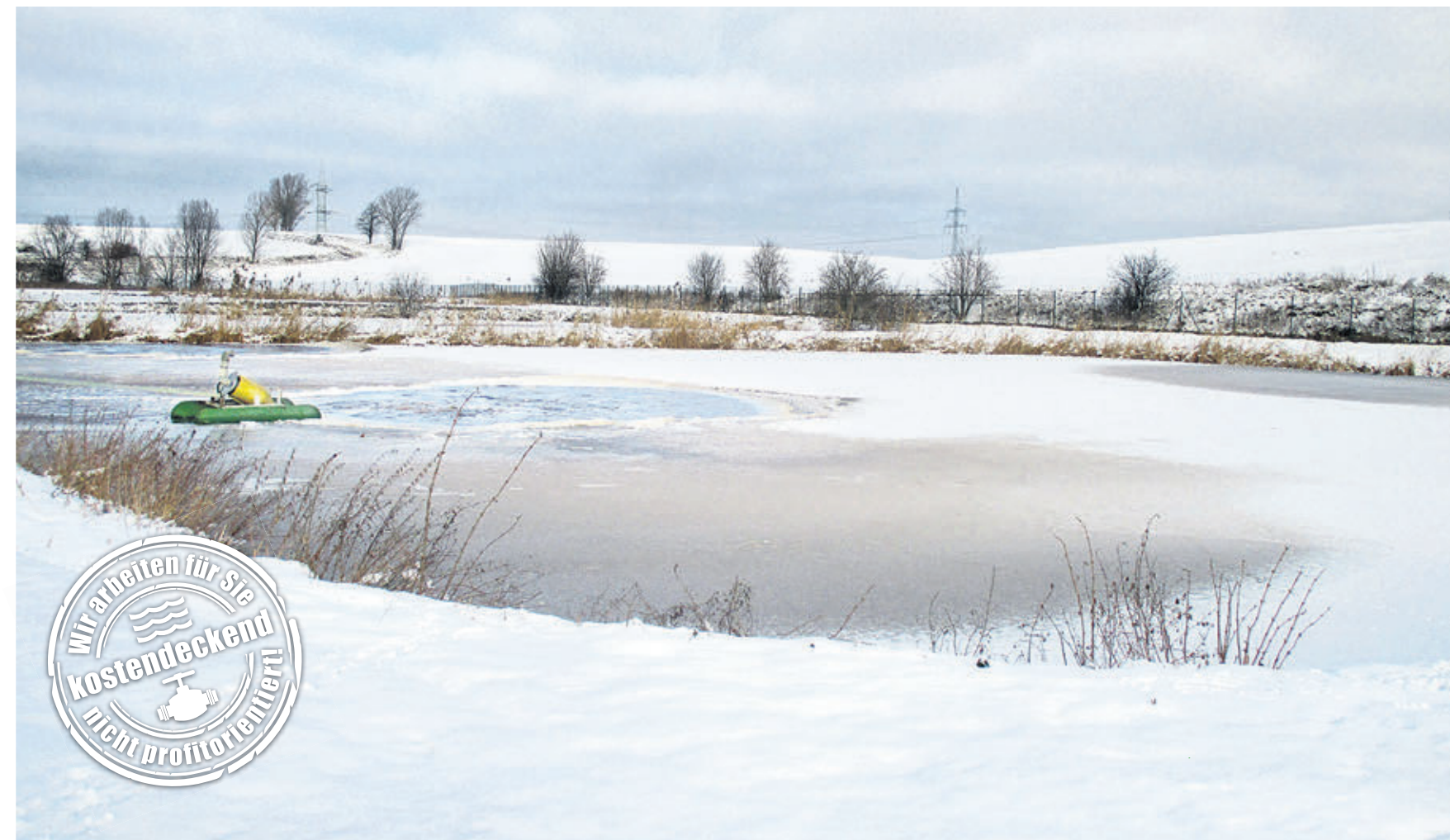
Teichkläranlagen wie in Nordgermersleben fügen sich harmonisch in die Natur ein. Oft entstehen hier Biotope als Lebensraum für eine Vielzahl heimischer Tierarten.
