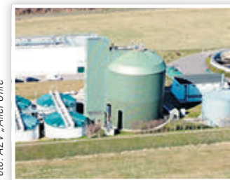
Kläranlage Weißenfels: Im Faul-turm wird Gas für die Blockheiz-kraftwerke gespeichert. Foto: Abwasserbeseitigung Weißenfels-AöR
