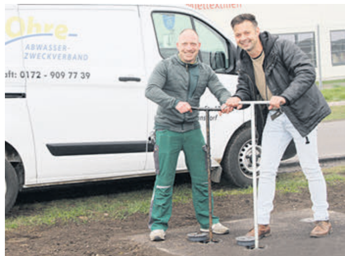
Ein Bild mit Symbolkraft: Christoph Wendt (l.), Abwassermeister beim AZV „Aller-Ohre“, sperrt den Zufluss zum WWAZ ab. Stephan Gerecke vom AVH öffnet den Schieber für das Abwasser Richtung Kläranlage Hillersleben des AVH „Untere Ohre“.
