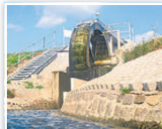
Seit 2012 wird beim Abwasser-verband Haldensleben „Untere Ohre“ Strom per Wasserrad erzeugt. Foto: AVH „Untere Ohre“
