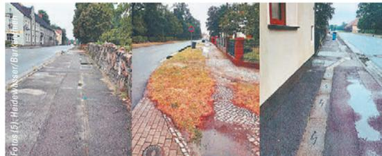
Über viele Jahre musste der Fußweg immer wieder geöffnet werden zur Neuverlegung von Versorgungskabeln. Nun steht mit der Erneuerung der Trinkwasserleitung die Sanierung des Weges an.
