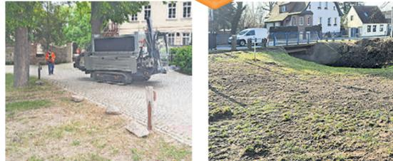
Am Münchentor in Loburg wurde die Trinkwasserleitung mit einem Gerät verlegt (links), das die Trasse für den Kanal unterirdisch freispült. So gelang der neue Kanal (Düker) unter der Ehle.
