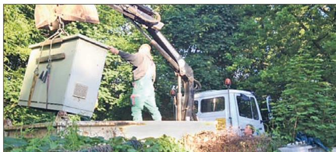
Der Schaltschrank für das Hauptpumpwerk Plötzky konnte rechtzeitig demontiert und vor den Wassermassen evakuiert werden.
