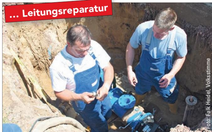
... die Heidewassermonteur Dennis Fippl und Sven Schulz mussten zunächst die Schieber schließen, dann konnten sie an die Reparatur gehen. Eine Notleitung wurde gelegt. Nach stundenlanger Arbeit hatten alle Betroffenen wieder ihr Trinkwasser mit dem gewohnten Druck.
