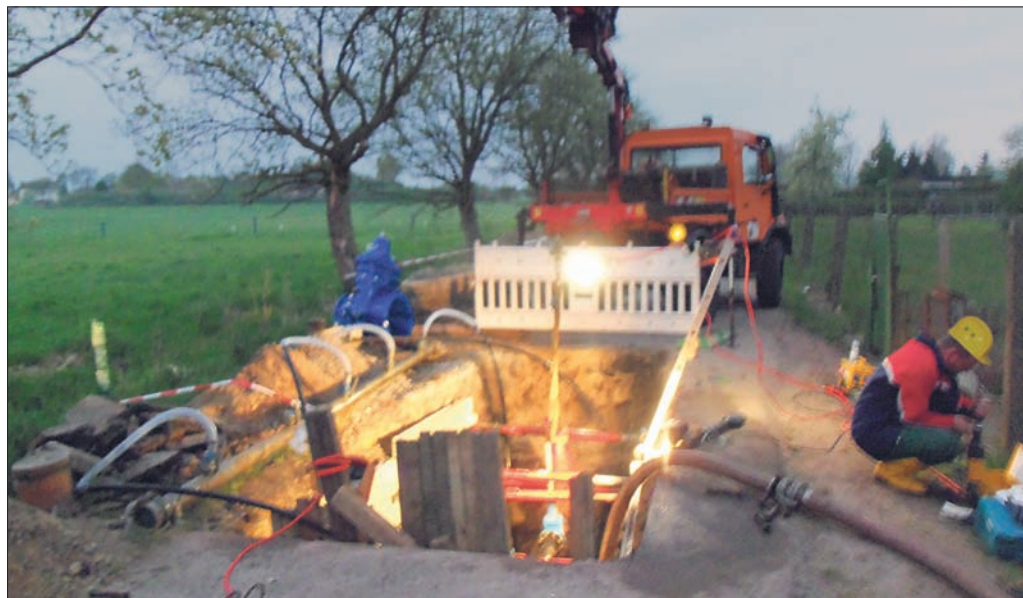
Alles lief wie geplant: Bis zum Morgengrauen waren die Baugrube gesichert und die Abwasserleitung leergespült. 180 Kubikmeter Schmutzwasser mussten zwischengespeichert werden.
