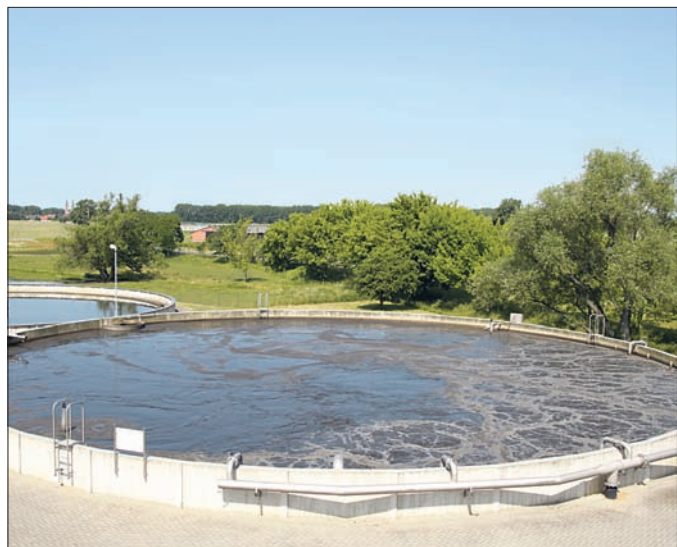
„Turbulenzen“ im Belebungsbecken kurbeln die Reinigung an.
