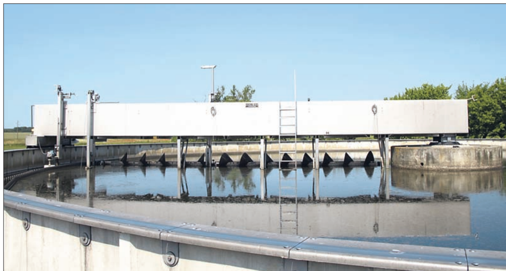
Im Nachklärbecken säubert die Schlammschnecke der Räumerrücke die Wasseroberfläche.
