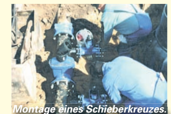
Montage eines Schieberkreuzes.
