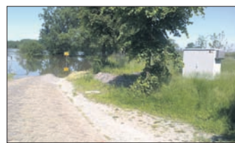
Der Schaltschrank des Pumpwerks Gönitz geriet in Gefahr.
