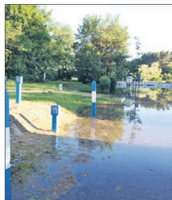
Das Hochwasser näherte sich dem Hauptpumpwerk in Plötzky.
