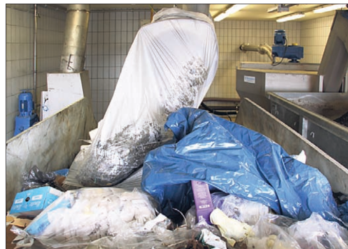
Alles, was der Rechen aus dem Abwasser geholt hat, wird in Container geleitet und zur Müllhalde transportiert.
