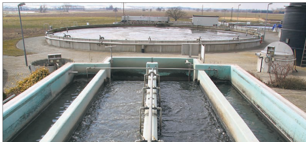
Sandfang und Vorklärbecken gehören zum ersten Abwasser-Waschgang in Kläranlagen.
