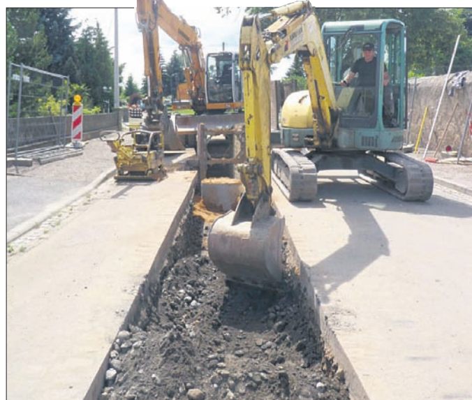
Da kommt was auf Sie zu! Der AVH legt auch 2013 neue Rohre.
