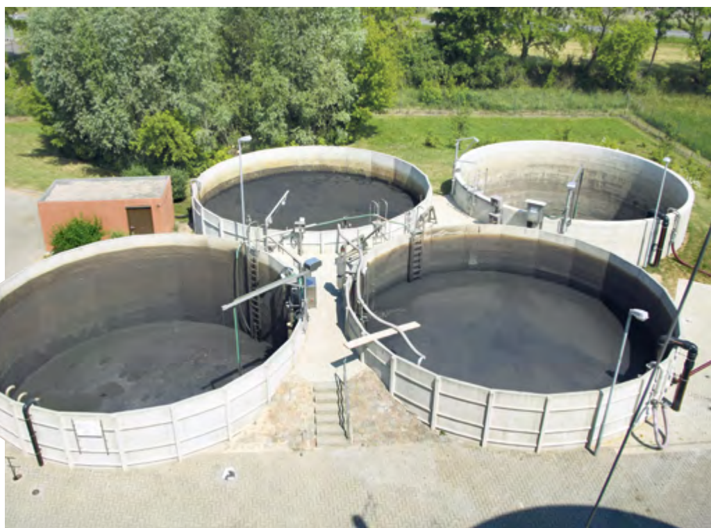
In den Schlammmeindickern wird die anfallende Masse gespeichert und vorentwässert.
