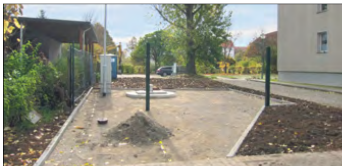
Aus dem alten Pumpwerk (oben) wurde eine moderne Anlage.
