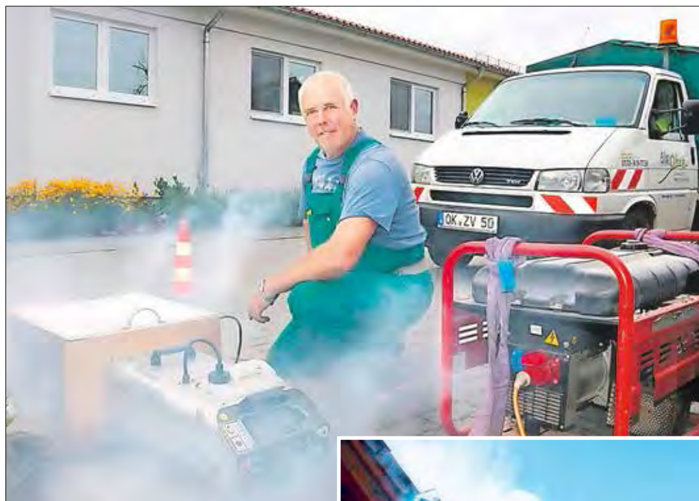
Klärwärter Heiko Pesch testet die Nebelmaschine auf dem Betriebshof des AZV-Sitzes in Behnsdorf. Bei Dachentwässerungen, die an den Schmutz- oder Niederschlagswasserkanal angeschlossen sind, finden die Nebelschwaden schnell ihren Weg bis zur Dachrinne (kl. Bild).
