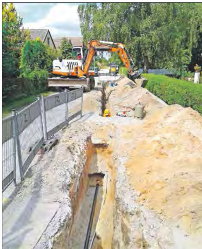
Im Ortsteil Bahnhof in Flechtingen verlegt der AVH Druckleitungen.
