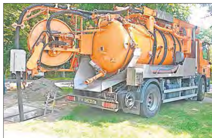
Während der Pumpwerksabschaltung wurde das Schmutzwasser mit diesem Wagen abgesaugt und dezentral entsorgt.
