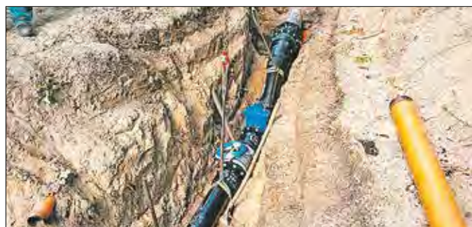
Hier wird das MID an der Abwasserleitung angebracht.
