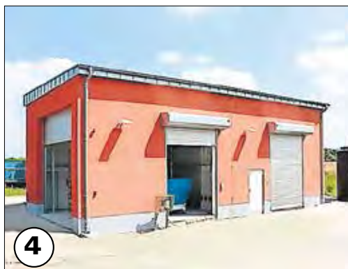
Die Verwandlung der Rechenhalle auf der Kläranlage Loburg in mehreren Stufen: Das alte Gebäude (1) wurde abgerissen und ein neues um den eingehausten Rechen herum gemauert (2, 3), hinzu kamen ein neues Dach, Fenster und Tore sowie frischer Putz und Farbe (4).
