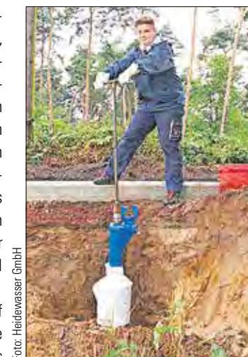
Tom Reich am Wasserschieber.
