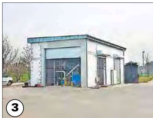
Die Verwandlung der Rechenhalle auf der Kläranlage Loburg in mehreren Stufen: Das alte Gebäude (1) wurde abgerissen und ein neues um den eingehausten Rechen herum gemauert (2, 3), hinzu kamen ein neues Dach, Fenster und Tore sowie frischer Putz und Farbe (4).
