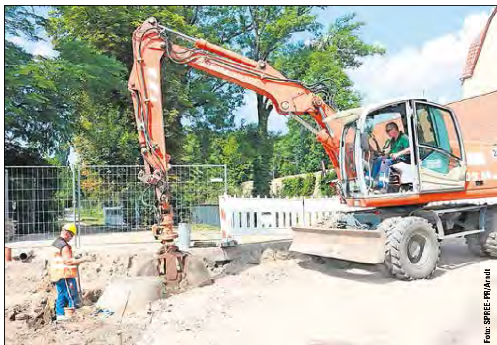
In der Jeverschen Straße in Zerbst verlegt der AWZ Elbe-Fläming neue Schmutzwasserkanäle.
