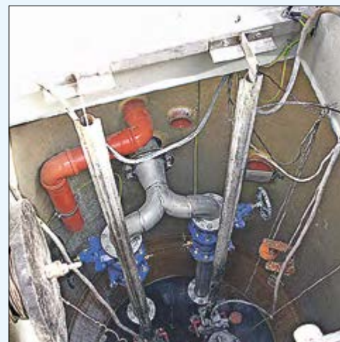
Blick in den Schacht des Pumpwerks nach der Sanierung.
