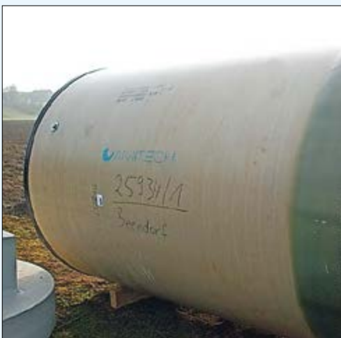
Eine Spezialfirma setzte den neuen Pumpenschacht fachgerecht ein.
