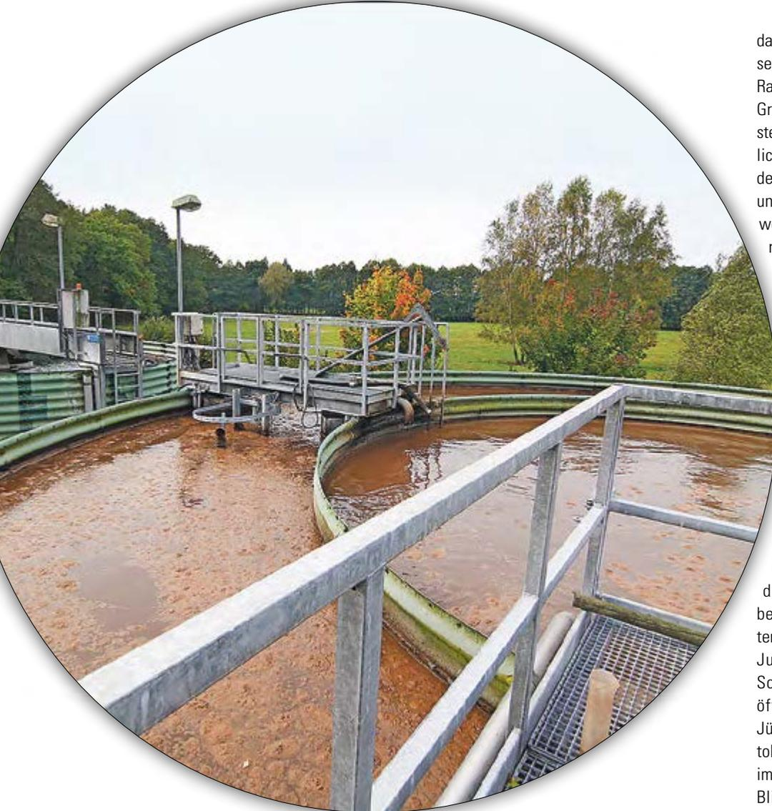
**Die Kläranlage Hundeluft wird runderneuert und zugleich erweitert. Die alten Metallbehälter der Nachklärbecken sind korrodiert und werden durch zeitgemäße aus Beton ersetzt.**
