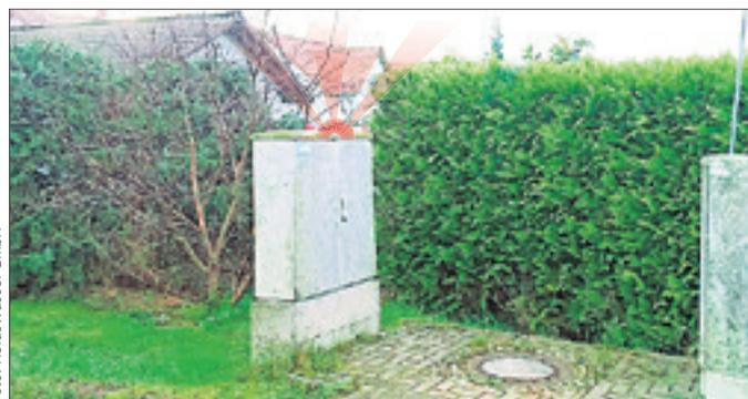
**Blinkt die rote Signalleuchte, ist die Pumpe gestört.**
